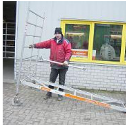
3. Plaats de opbouwhulp aan het opbouwframe.
