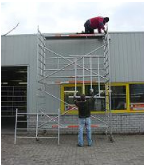
15. Volgende juk opsteken of omhoog hijsen met behulp van een touw.
