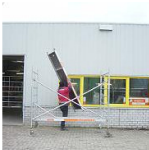
7. Plaats de loopplank.
