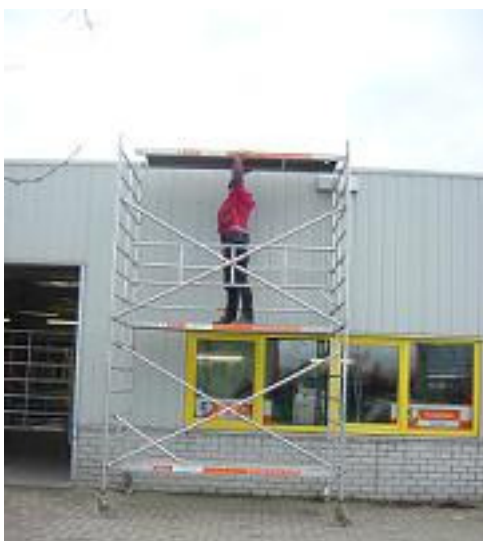
13. Plaats de 2 e loopplank.
