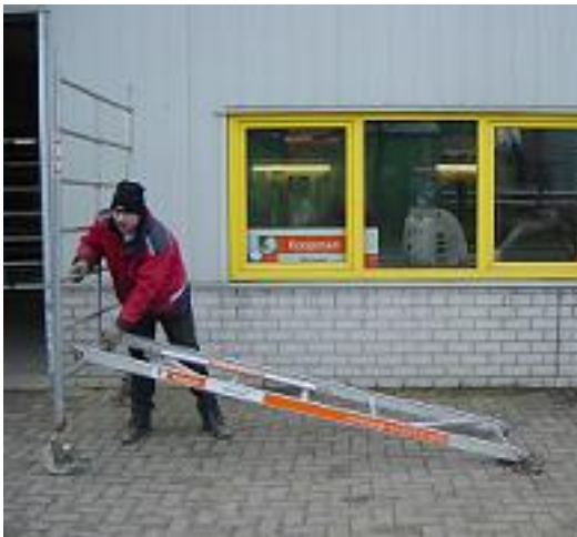
2. Plaats opbouwframe op de 1 e spot.
